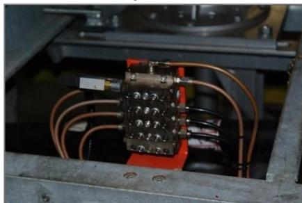
**Централизованная система смазки**
